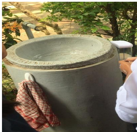
Gambar 1. Fasilitas cuci tanga yang dilengkapi dengan sabun dan lap
