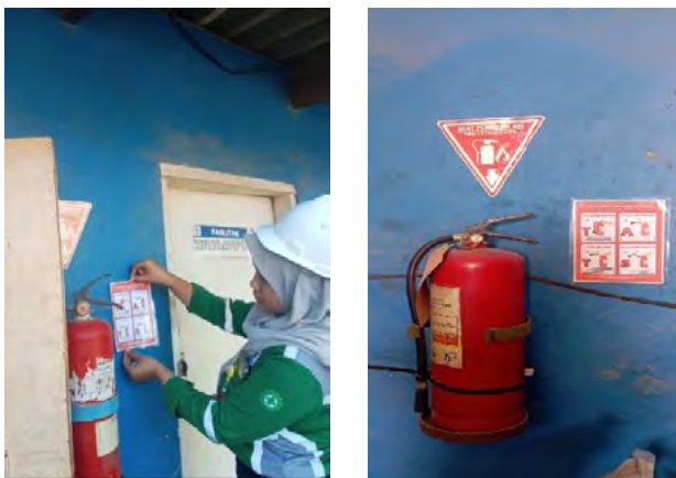
Gambar 6. Pemasangan Rambu Penempatan dan Cara Penggunaan APAR
