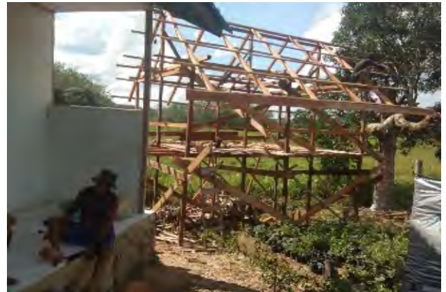
Gambar 2. Rangka Rumah Baca
