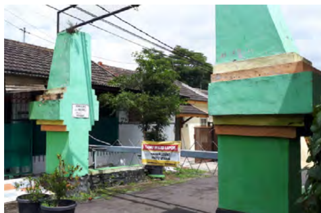
Gambar 1. Konstruksi Pergola dari Bahan Bata Di Antara Blok G Dan Blok H Sebelum Dibongkar
