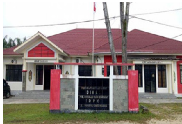
Gambar 1. Gedung Kearsipan Kabupaten Landak
