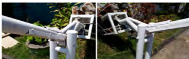
Gambar 1. Pipa Utama Portal diperkuat dengan Bahan Pelat Baja Siku-Siku di Sekeliling Bagian Engselnya
