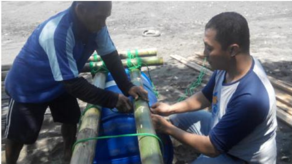
Gambar Q Pengikatan rangka atas dengan pengapung/Floater
