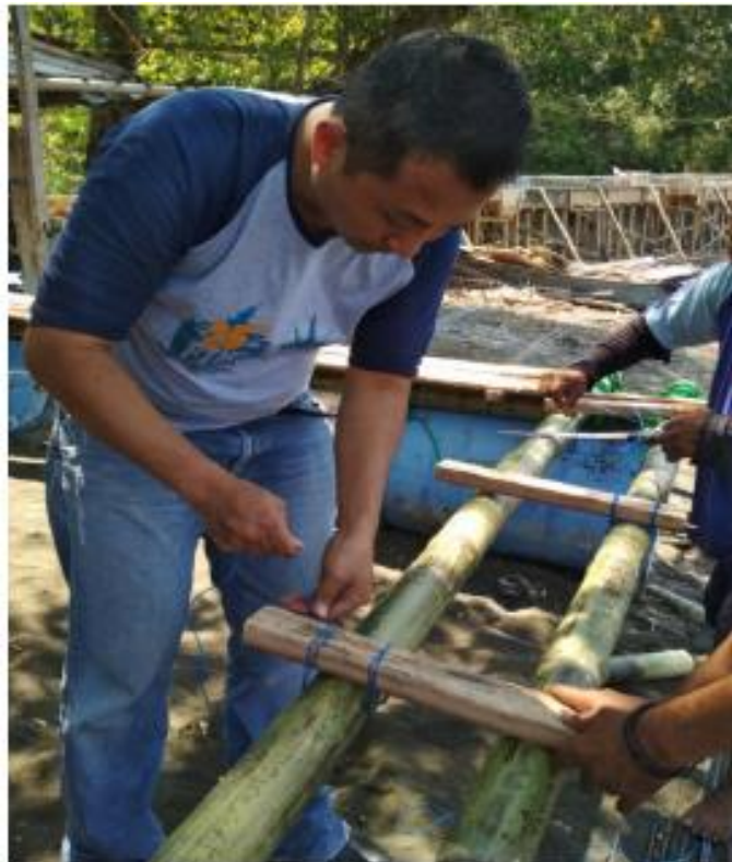
Gambar X Pengikatan rangka alas kayu sebagai tumpuan papan kayu untuk orang jalan
