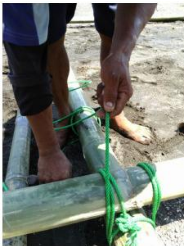
Gambar J Pengikatan berulang ulang
