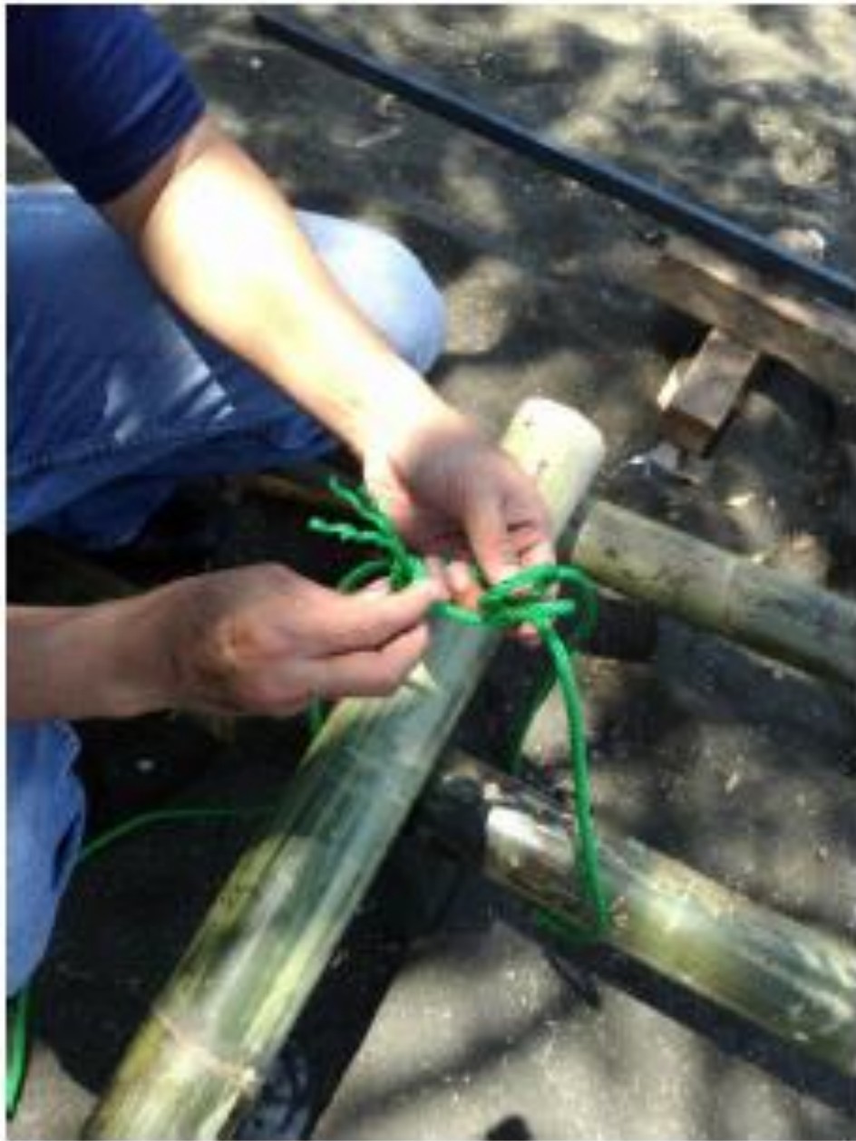
Gambar F Pengikatan awal (dilakukan pada bambu paling bawah)
