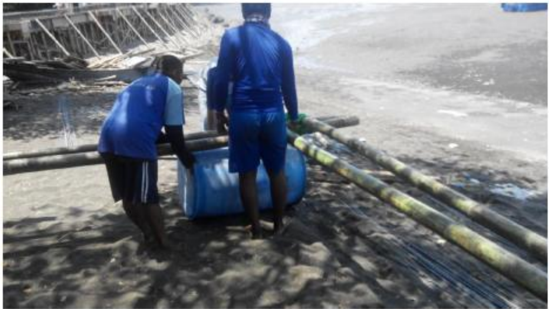
Gambar O Pemasangan rangka atas dengan pengapung/Floater
