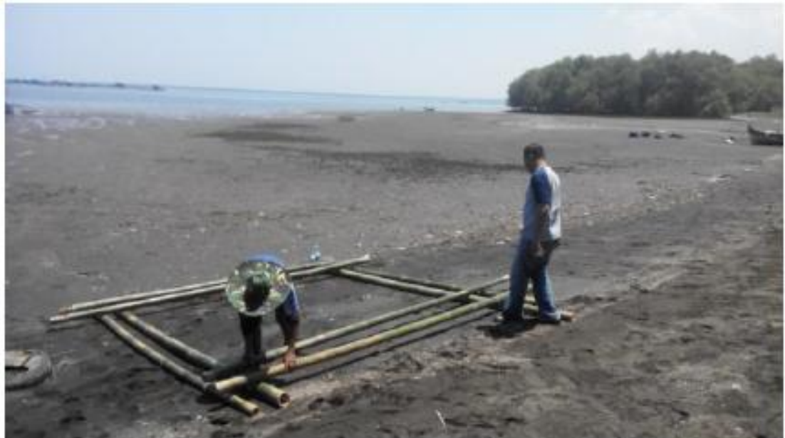
Gambar E penataan struktur kerangka atas.
