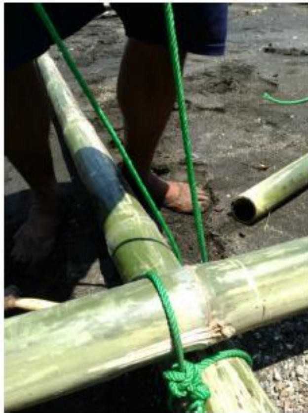
Gambar H Penyambungan rangka bambu atas dan bawah
