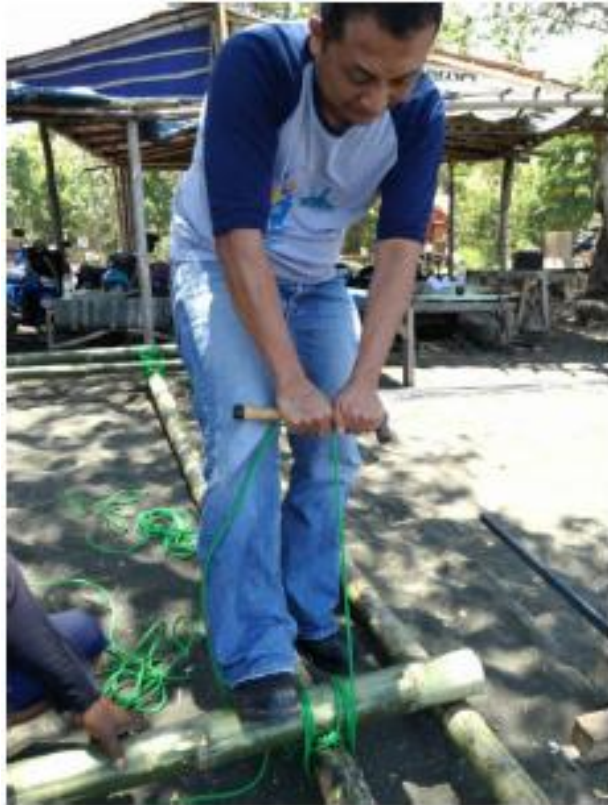
Gambar K Pengencangan pengikatan
