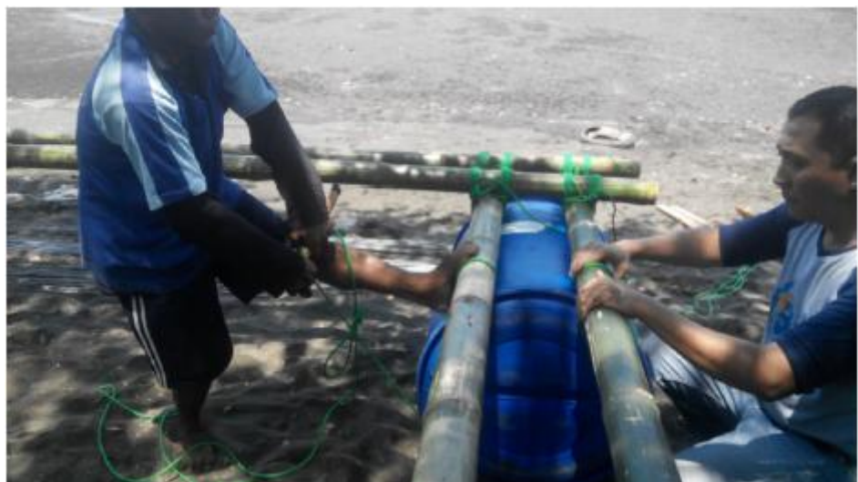
Gambar S Pengencangan ikatan
