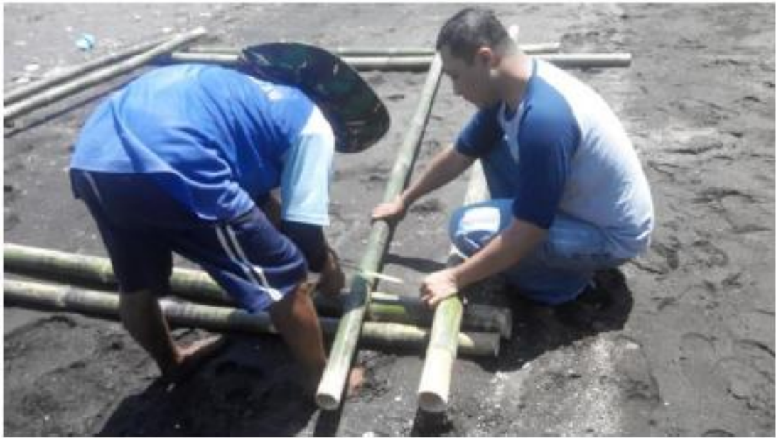
Gambar D pengukuran Jarak antar Bambu
