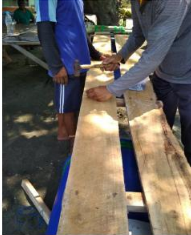
Gambar Y Pemasangan papan kayu untuk orang jalan
