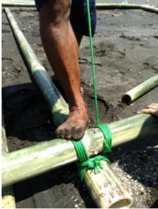
Gambar M Ikatan melingkar horizontal sudah terbentuk
