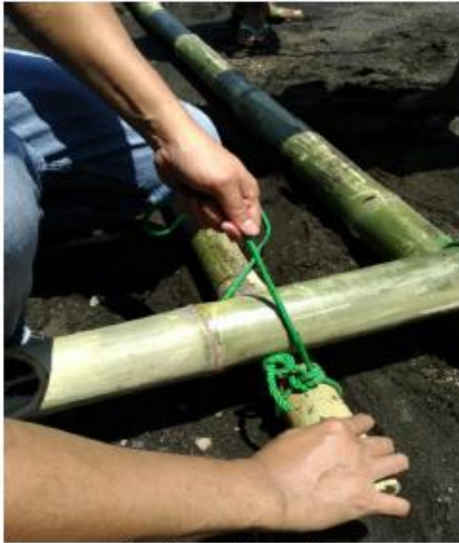
Gambar G Pengikatan dikencangkan
