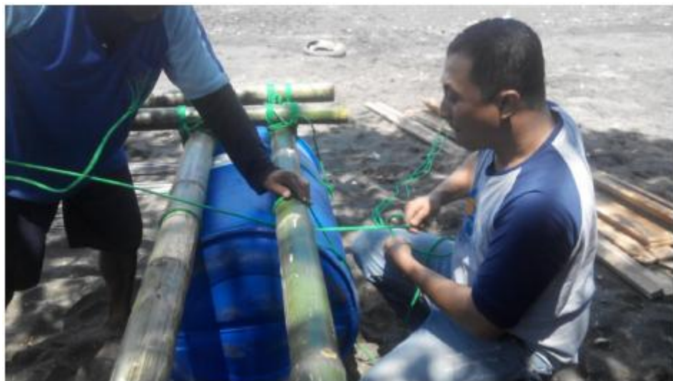
Gambar R Pengikatan rangka atas dengan pengapung/Floater (berulang ulang)
