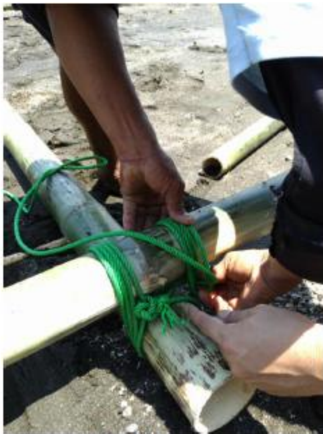
Gambar L Membuat ikatan melingkar horizontal (untuk memperkuat ikatan)
