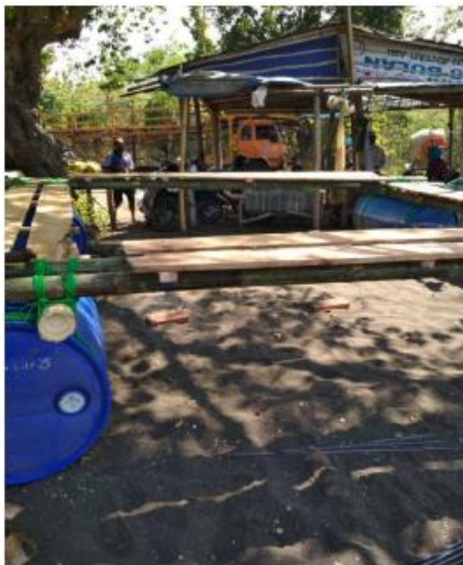
Gambar Z Bentuk Perakitan KJA yang telah selesai
