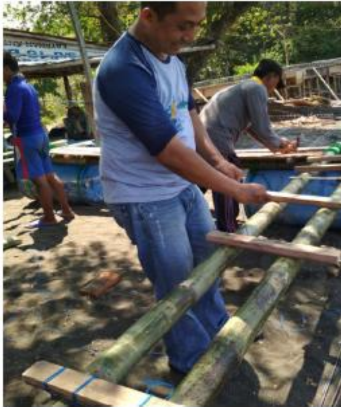
Gambar V Pemasangan rangka alas kayu sebagai tumpuan papan kayu untuk orang jalan
